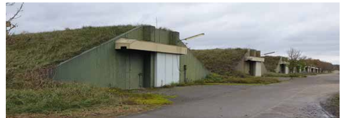
Figuur 10.3 NAVO bunkers (Bron: Functioneel Parket Amsterdam)
